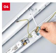
04 Schließen Sie das Netzkabel an den Klemmblock an.
