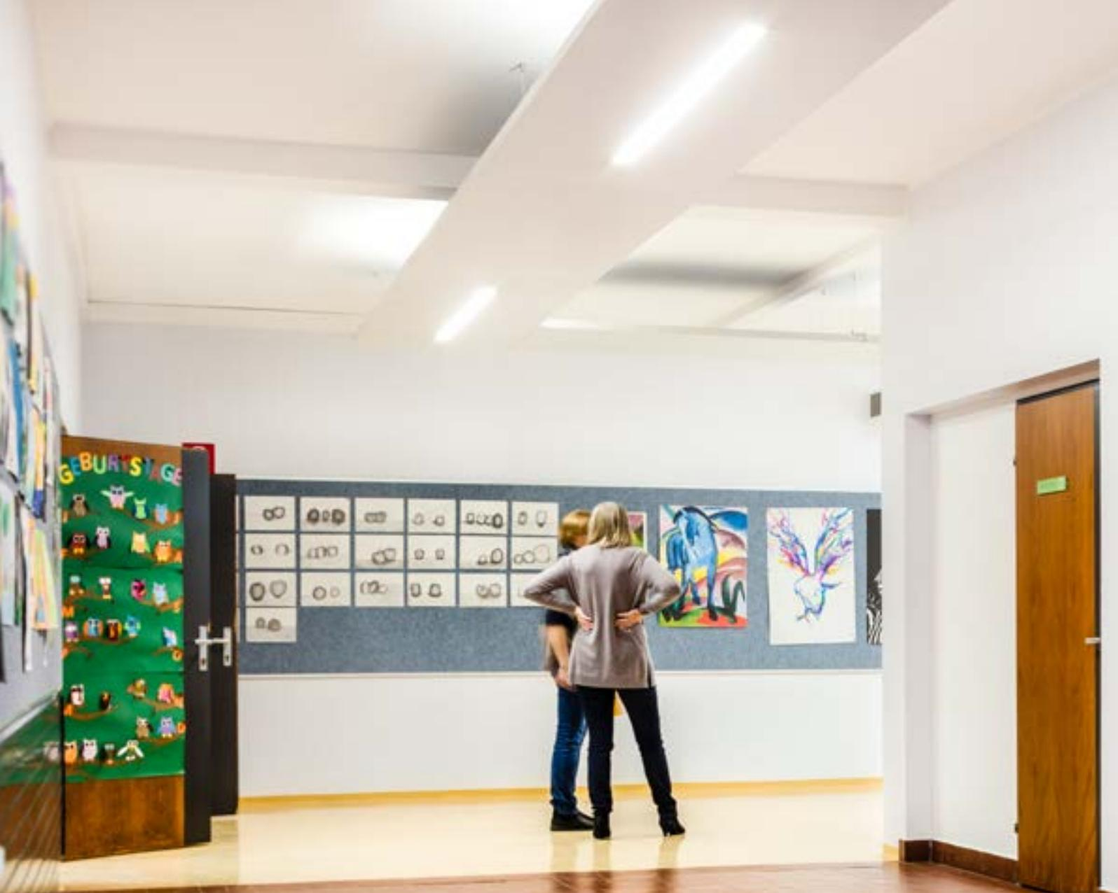
Die Arena Symphony Pendelleuchten von Thorn bestehen aus LED Modulen und Schalldämpfungseinlagen. Im gleichen Design sind auch sogenannte Leermodule mit ausschließlich akustischem Material erhältlich. So können mit diesem flexiblen System in jeder Raumsituation lichttechnische und akustische Anforderungen bestmöglich erfüllt werden.
